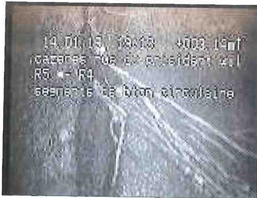
Photo: 6_6_18_A.JPG, N° support: 2-14012018 c_7 3,14m, Radicelles à 8 h. réduction de la section transversale: 1 %
