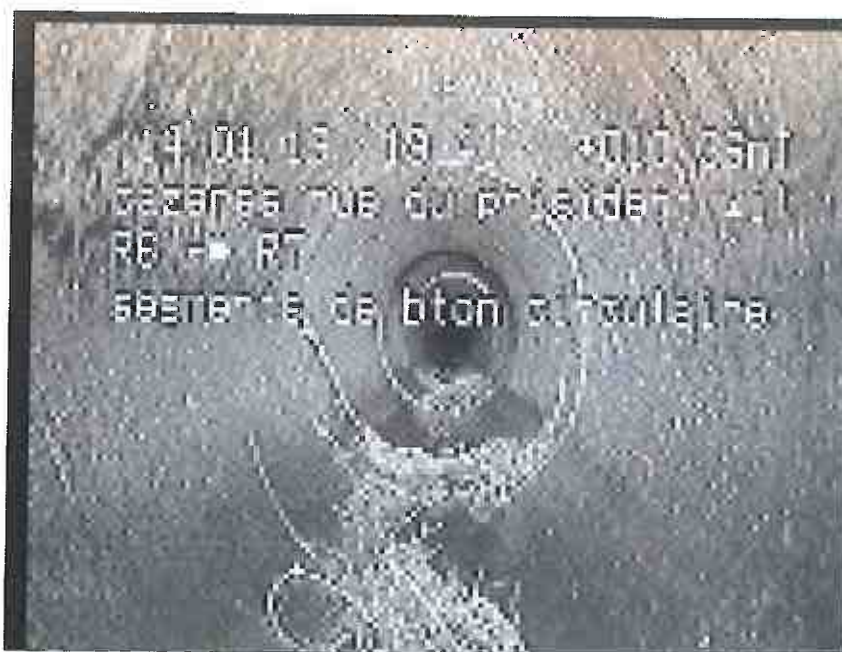
Photo: 8_8_29_A.JPG, N° support: 2-14012018 c_7 10,36m, Radicelles à 6 h. réduction de la section transversale: 2 %
