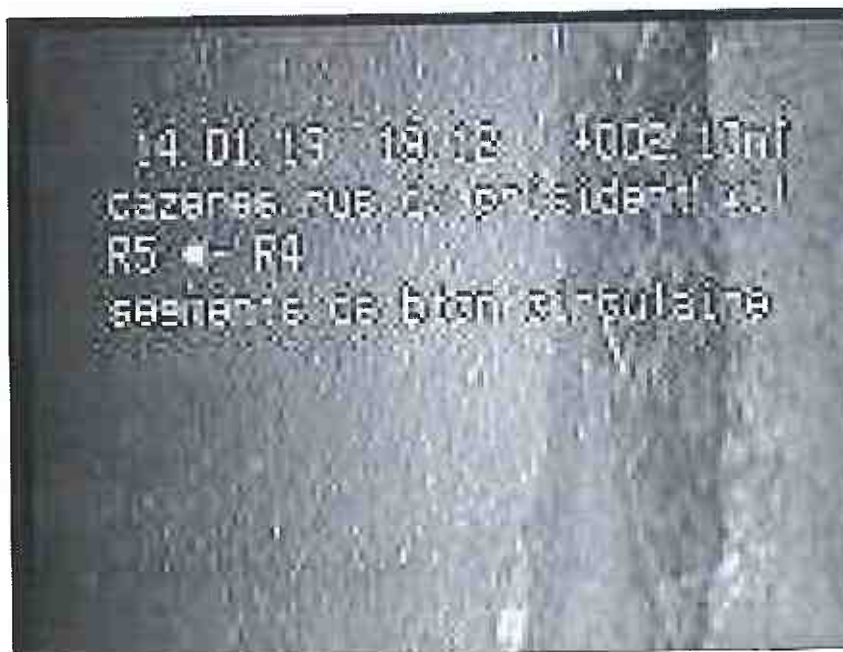
Photo: 6_6_17_A.JPG, N° support: 2-14012018 c_7 2,1m, Radicelles à 4 h. réduction de la section transversale: 1 %
