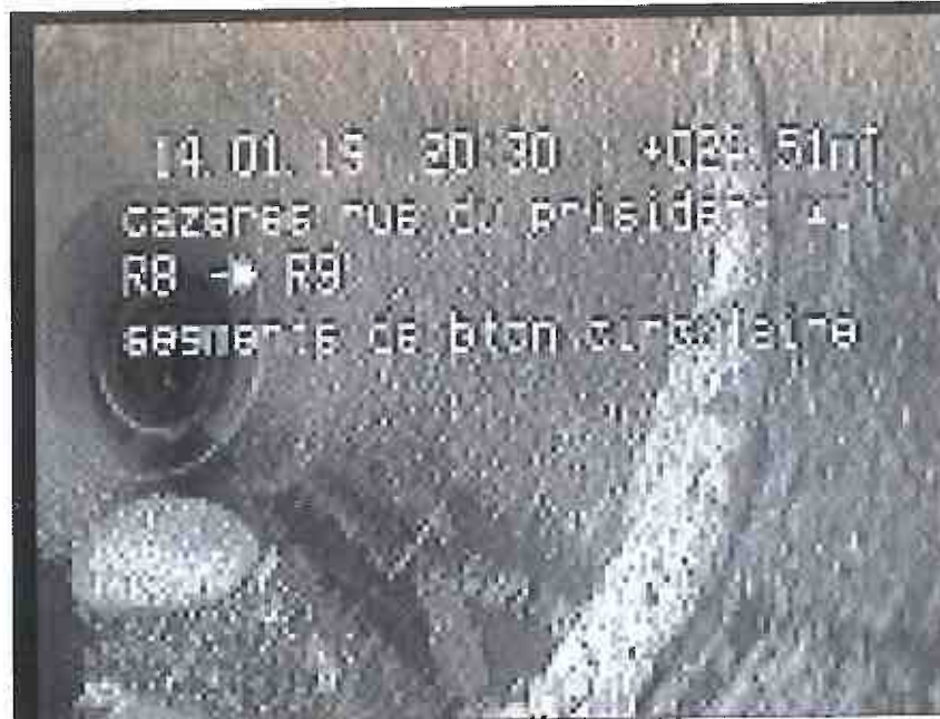
Photo: 11_11_48_A.JPG, N° support: 2-14012018 c_7 24,51m, Déplacement d'assemblage, radial de 3 à 9 h. déplacement: 50 mm
