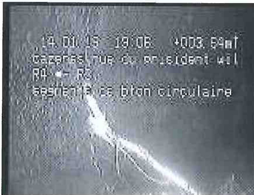
Photo: 5_5_11_A.JPG, N° support: 2-14012018 c_7 3,64m, Radicelles à 8 h. réduction de la section transversale: 1 %
