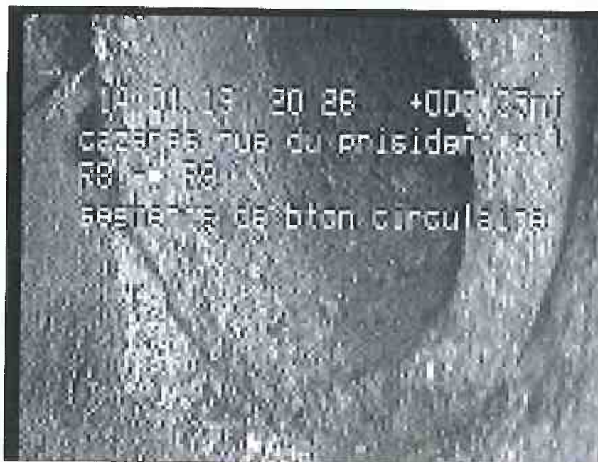
Photo: 11_11_47_A.JPG, N° support: 2-14012018 c_7 0,35m, Culotte, raccordement ouvert à 10 h., hauteur: 100 mm, (largeur: 100 mm)
