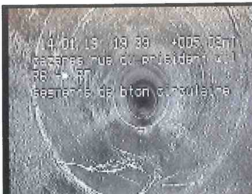
Photo: 8_8_27_A.JPG, N° support: 2-14012018 c_7 5,02m, Radicelles à 8 h. réduction de la section transversale: 1 %
