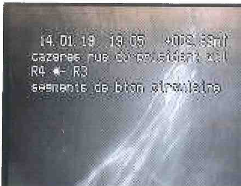
Photo: 5_5_10_A.JPG, N° support: 2-14012018 c_7 2,69m, Radicelles à 3 h. réduction de la section transversale: 2 %
