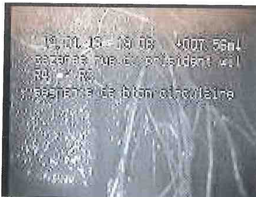
Photo: 5_5_14_A.JPG, N° support: 2-14012018 c_7 7,56m, Radicelles de 4 à 5 h. réduction de la section transversale: 2 %
