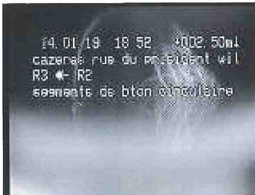
Photo: 4_4_7_A.JPG, N° support: 2-14012018 c_7 2,5m, Radicelles de 1 à 6 h. réduction de la section transversale: 20 %
