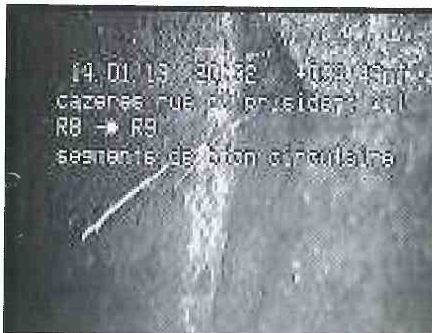
Photo: 11_11_50_A.JPG, N° support: 2-14012018 c_7 34,49m, Radicales à 4 h. réduction de la section transversale: 1 %
