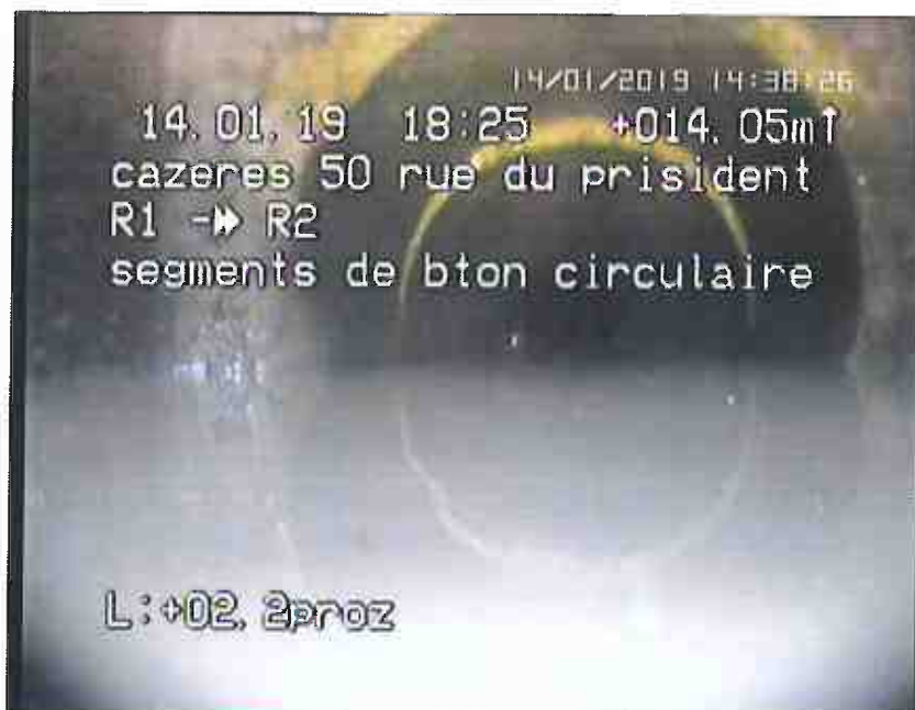
Photo: 2_2_3_A.jpg, N° support: 2-14012018 c_7, 00:02:07 14,05m, Noeud d'arrivée, regard de visite R2
