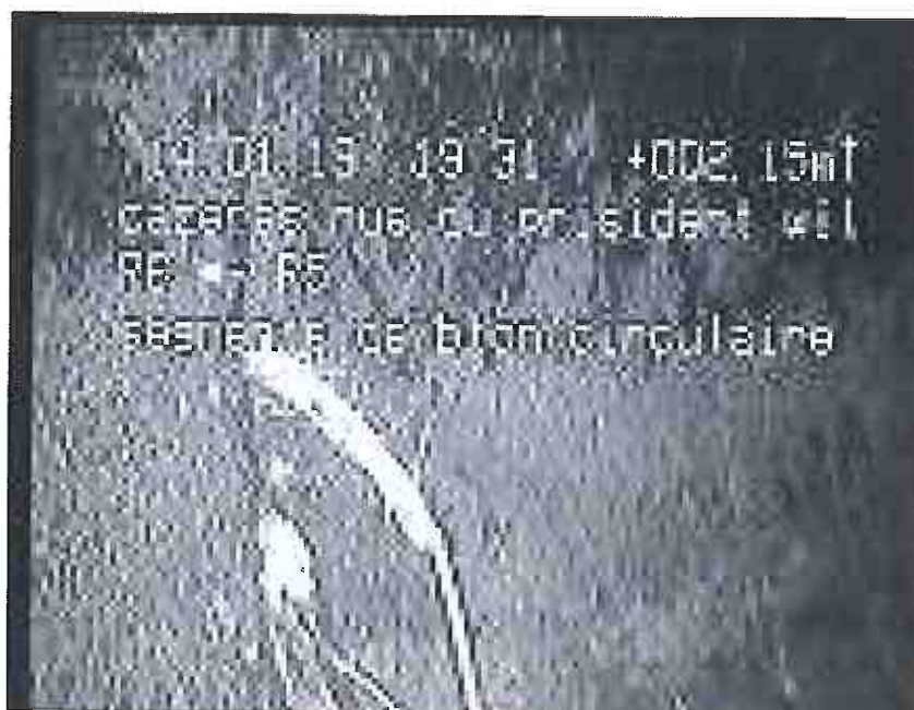
Photo: 7_7_22_A.JPG, N° support: 2-14012018 c_7 2,15m, Radicelles à 8 h. réduction de la section transversale: 1 %
