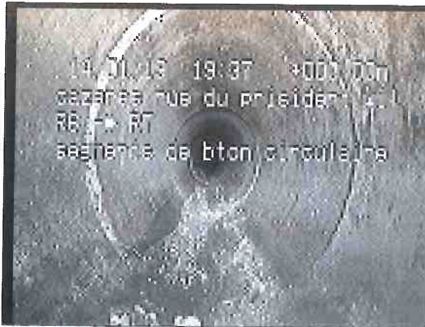
Photo: 8_8_24_A.JPG, N° support: 2-14012018 c_7 0m, Noeud de départ, regard de visite R6
